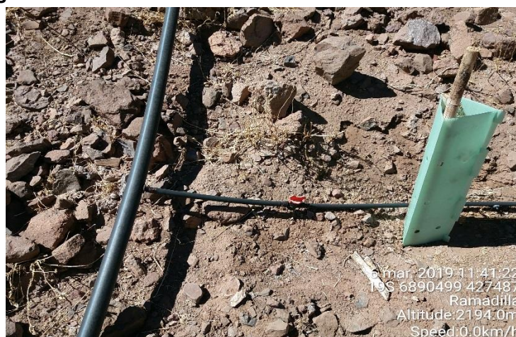
Figura 2-2: Unión de tubería de 16 mm con tubería de 1 ¼"
